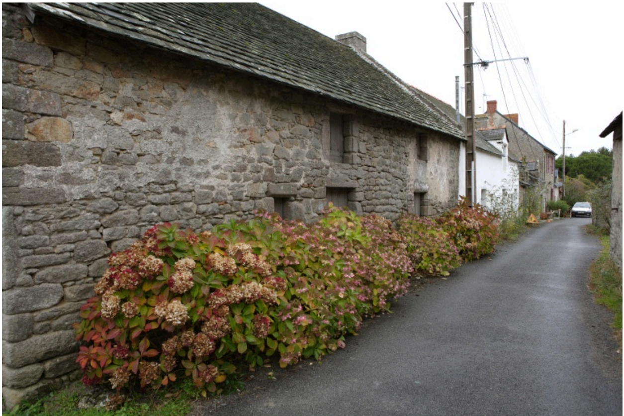
Vue d'ensemble de la rangée depuis l'est.
