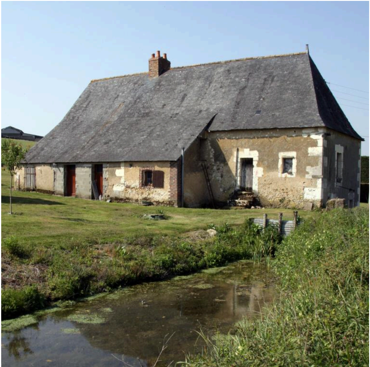
Vue de volume, en amont.
