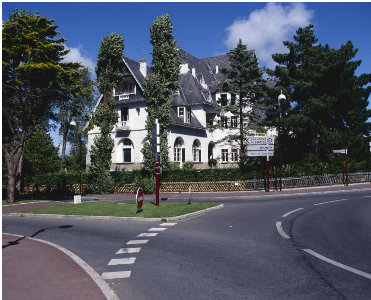
Façade sur avenue de Joyeuse et avenue du Maréchal-de-Lattre-de-Tassigny.
