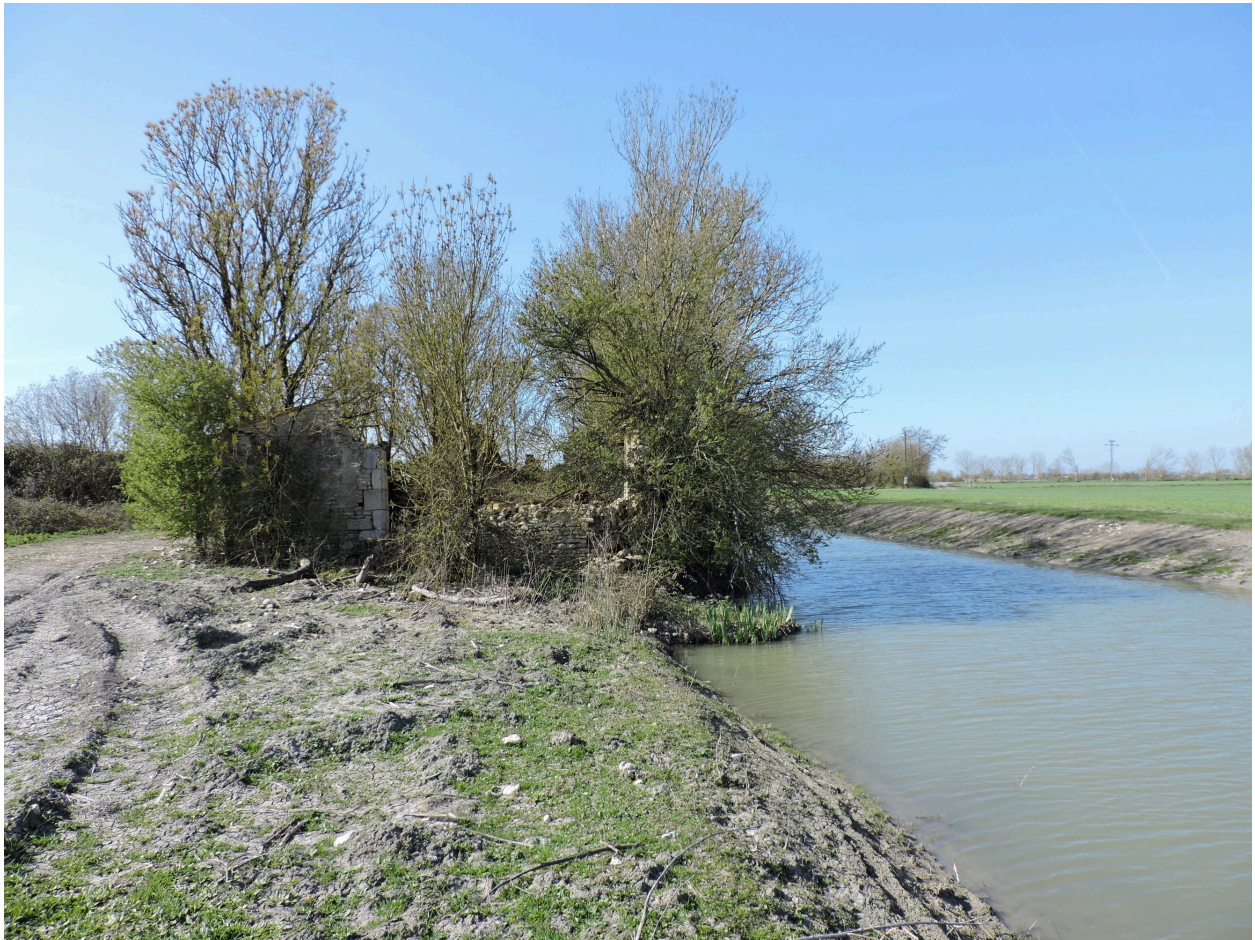
La grange-étable nord-est, le long du canal du Pont Tord, vue depuis le nord-est.
