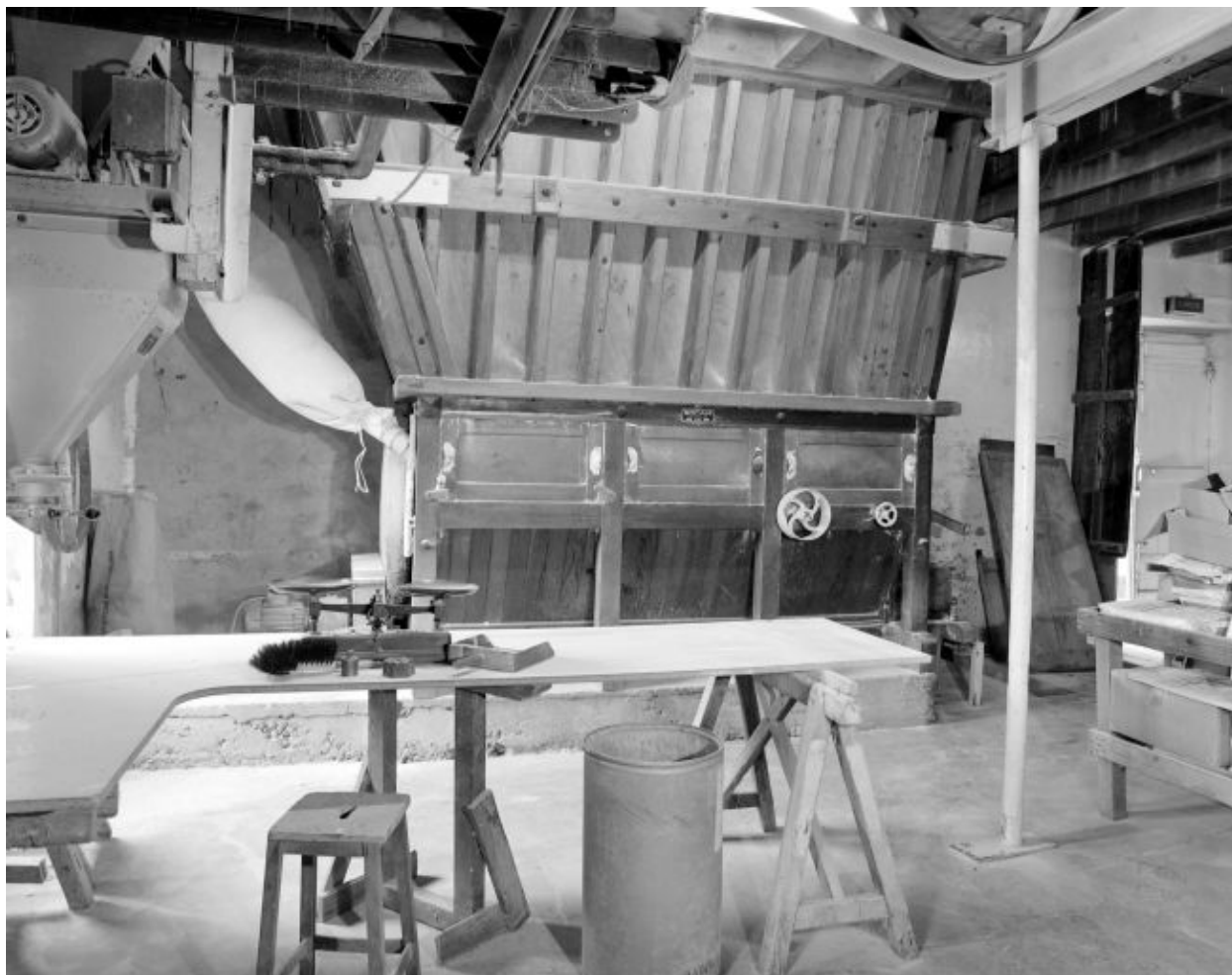
Rez-de-chaussée, partie sud-ouest. La mélangeuse.
