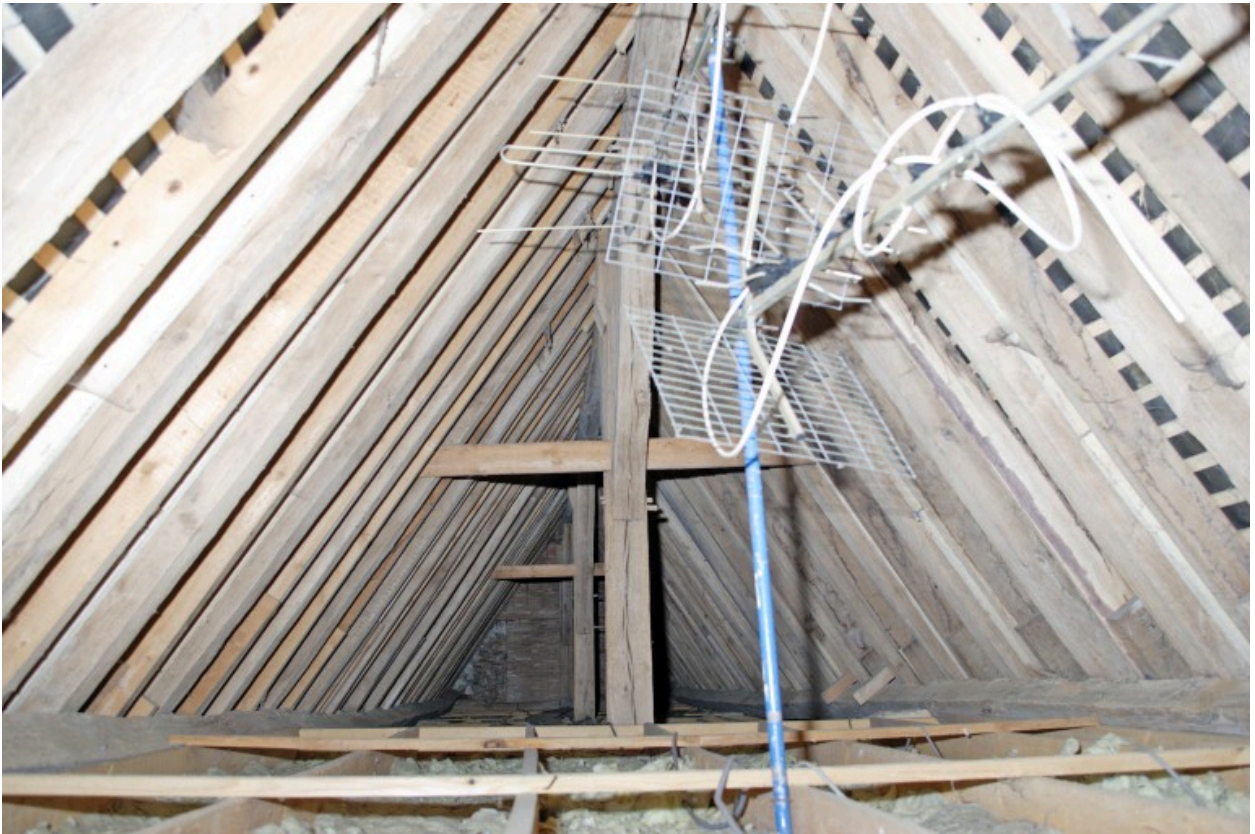
Comble du corps principal : la partie supérieure de la charpente vue depuis le nord.
