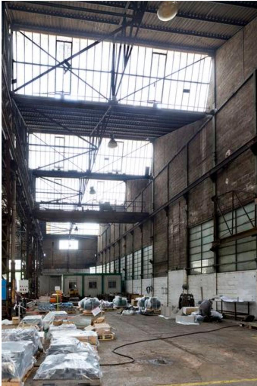
Atelier de découpe (n°2) : couverture en sheds, structure métallique et remplissage en briques.
