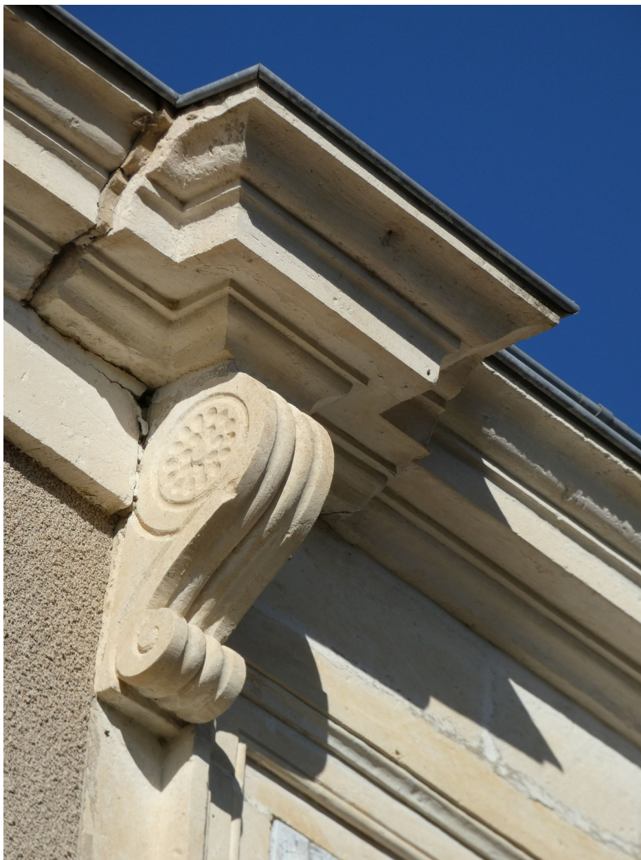
Détail d'une des consoles ornant la travée centrale d'ouvertures, au sud.
