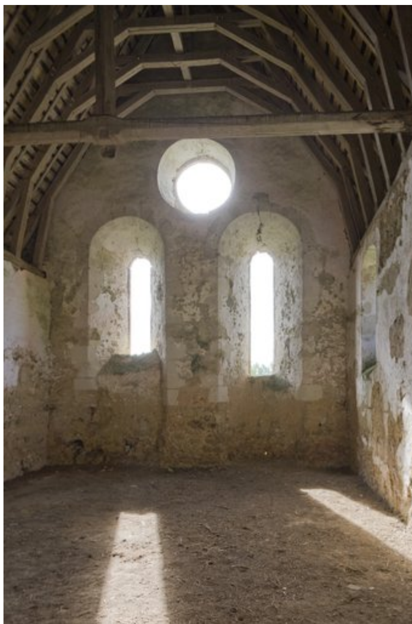
Vue d'ensemble du mur oriental.
