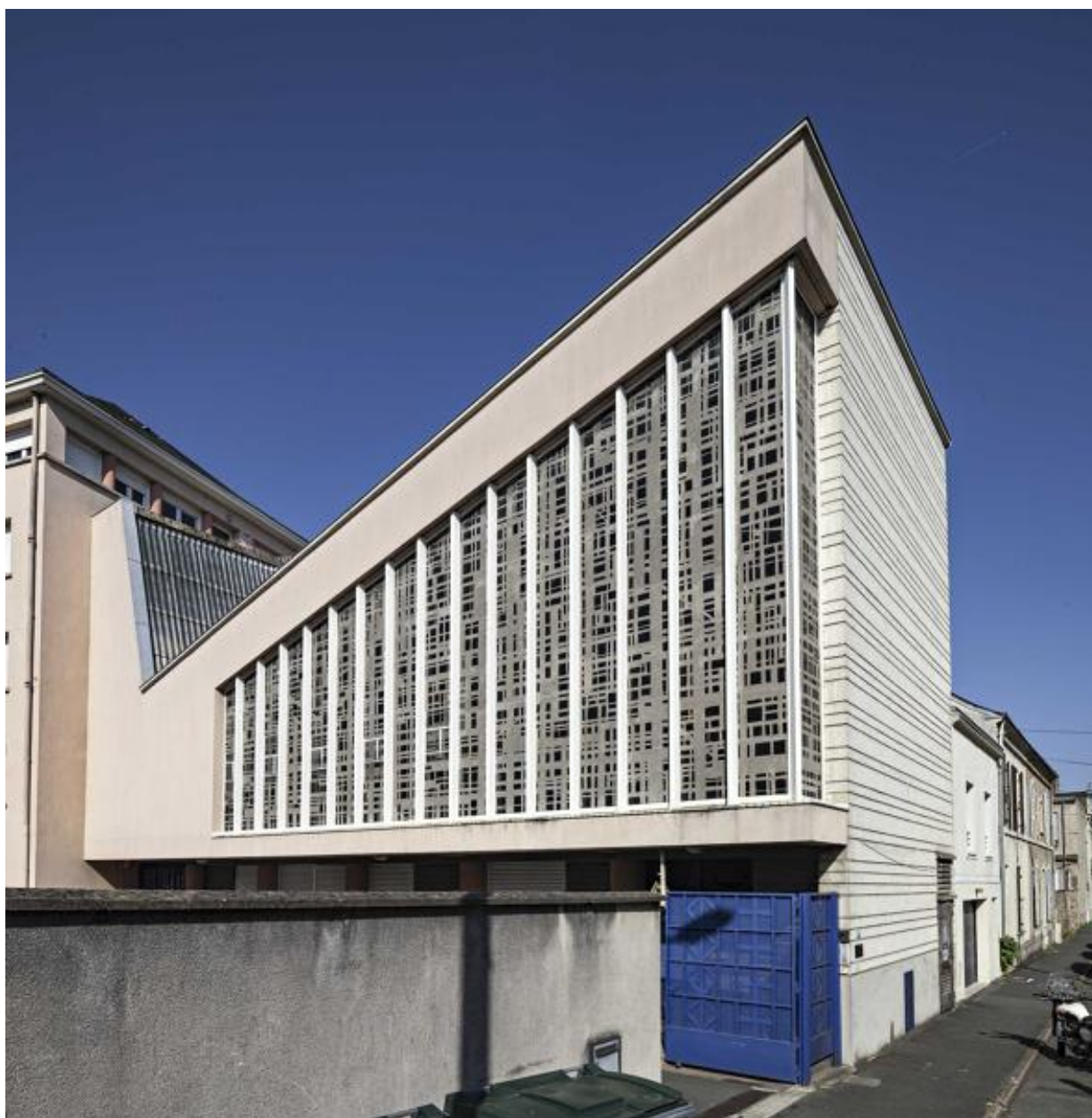
Vue du mur rideau depuis l'extérieur.
