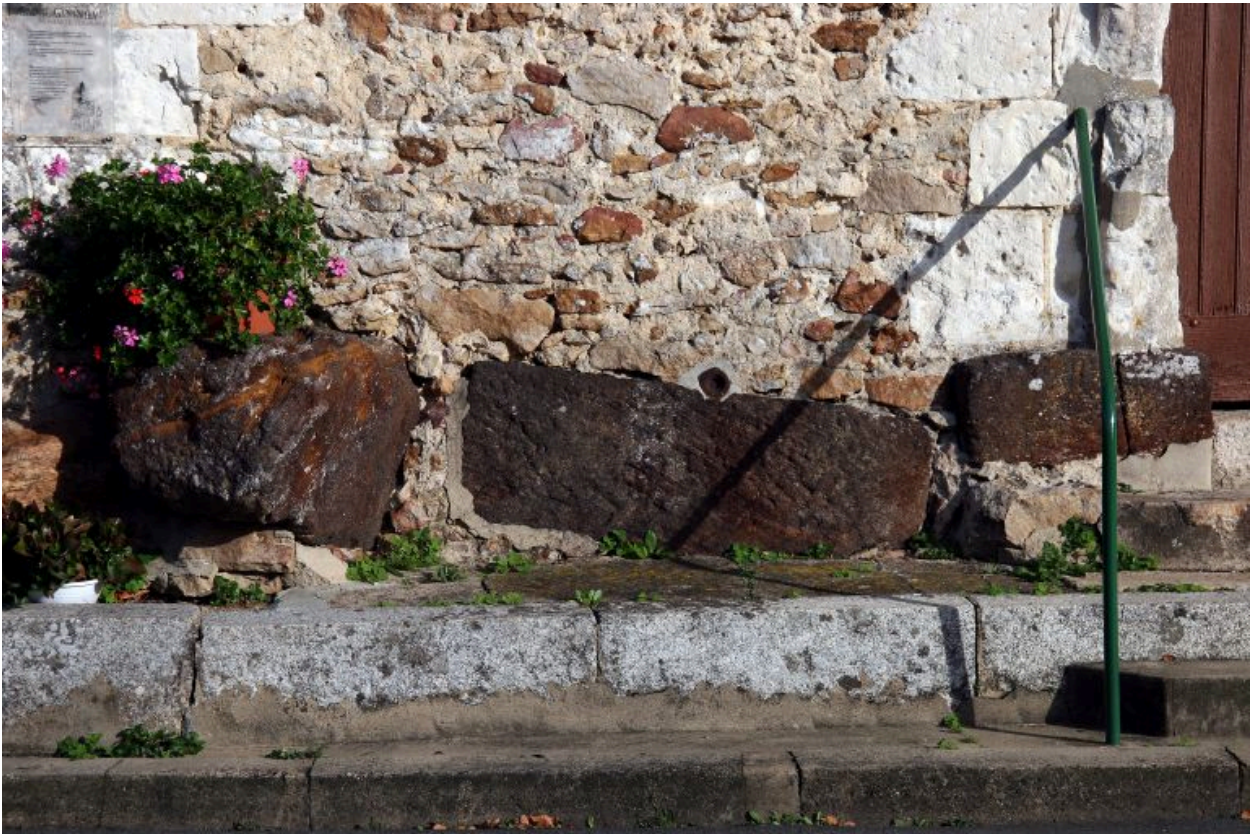
Façade occidentale : matériaux et mise en œuvre.
