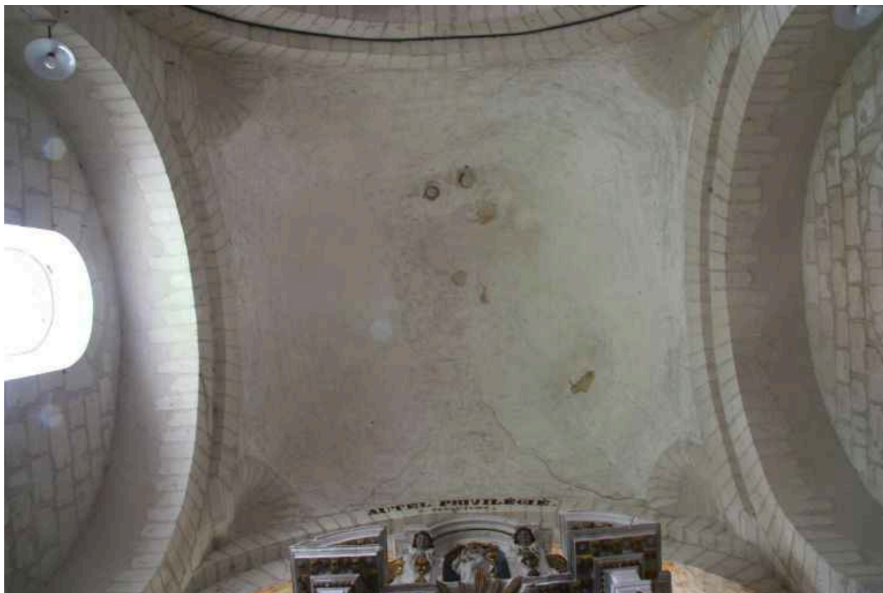
Voûte du chœur supportant le clocher.
