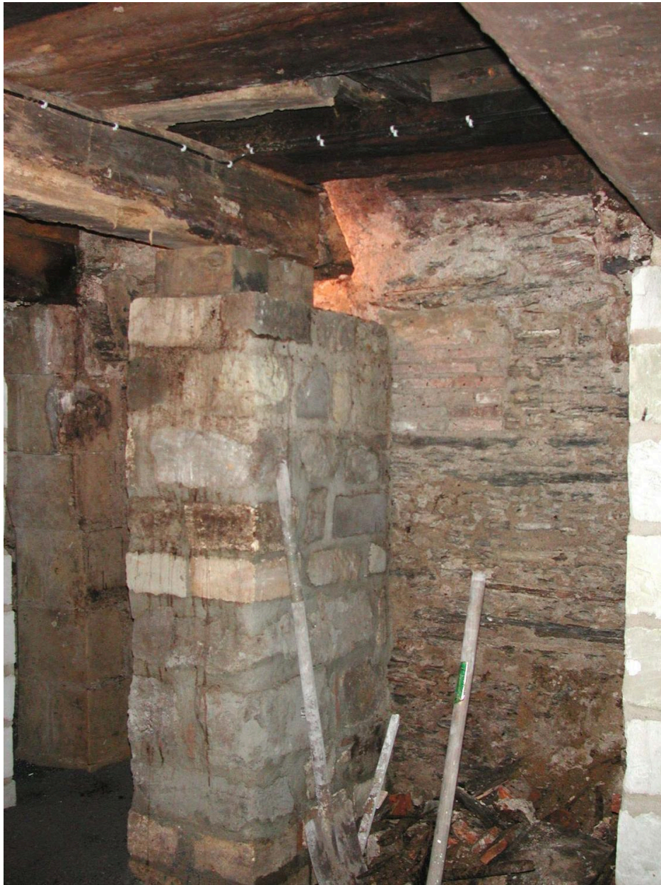
Sous-sol, élévation intérieure est, partie nord (vers la rue) : détail sur les vestiges du départ de la voûte supprimée lors de la réfection du plafond.
