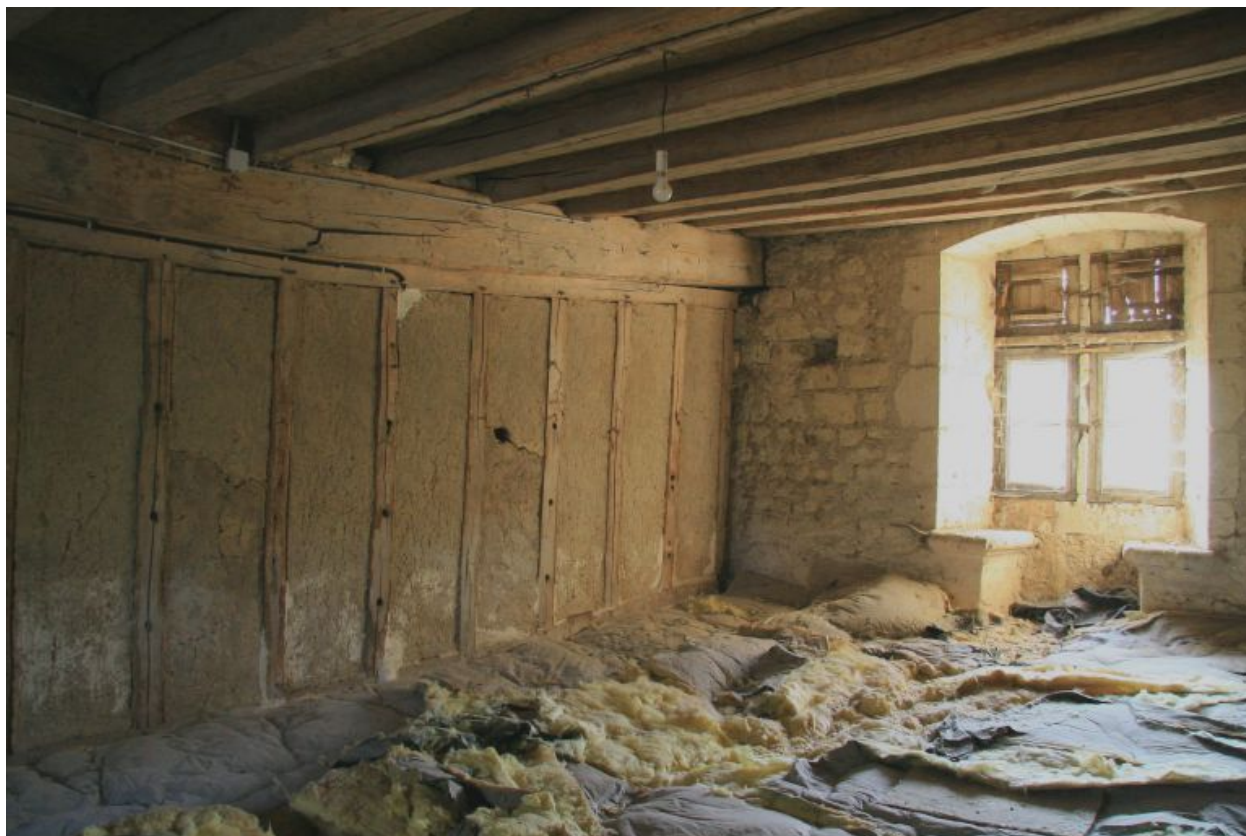
Bâtiment des greniers, 1er étage : salle ouest.
