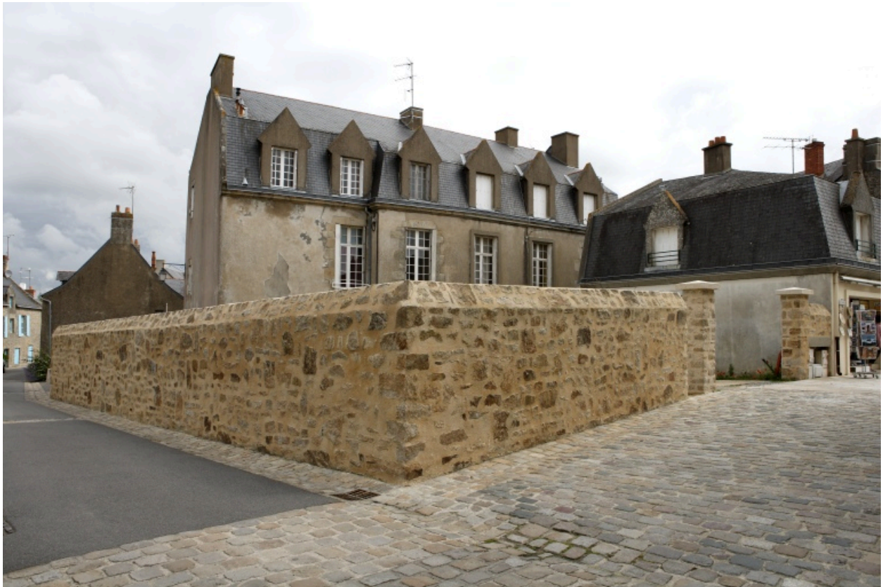
Vue générale vers le Nord-Est.
