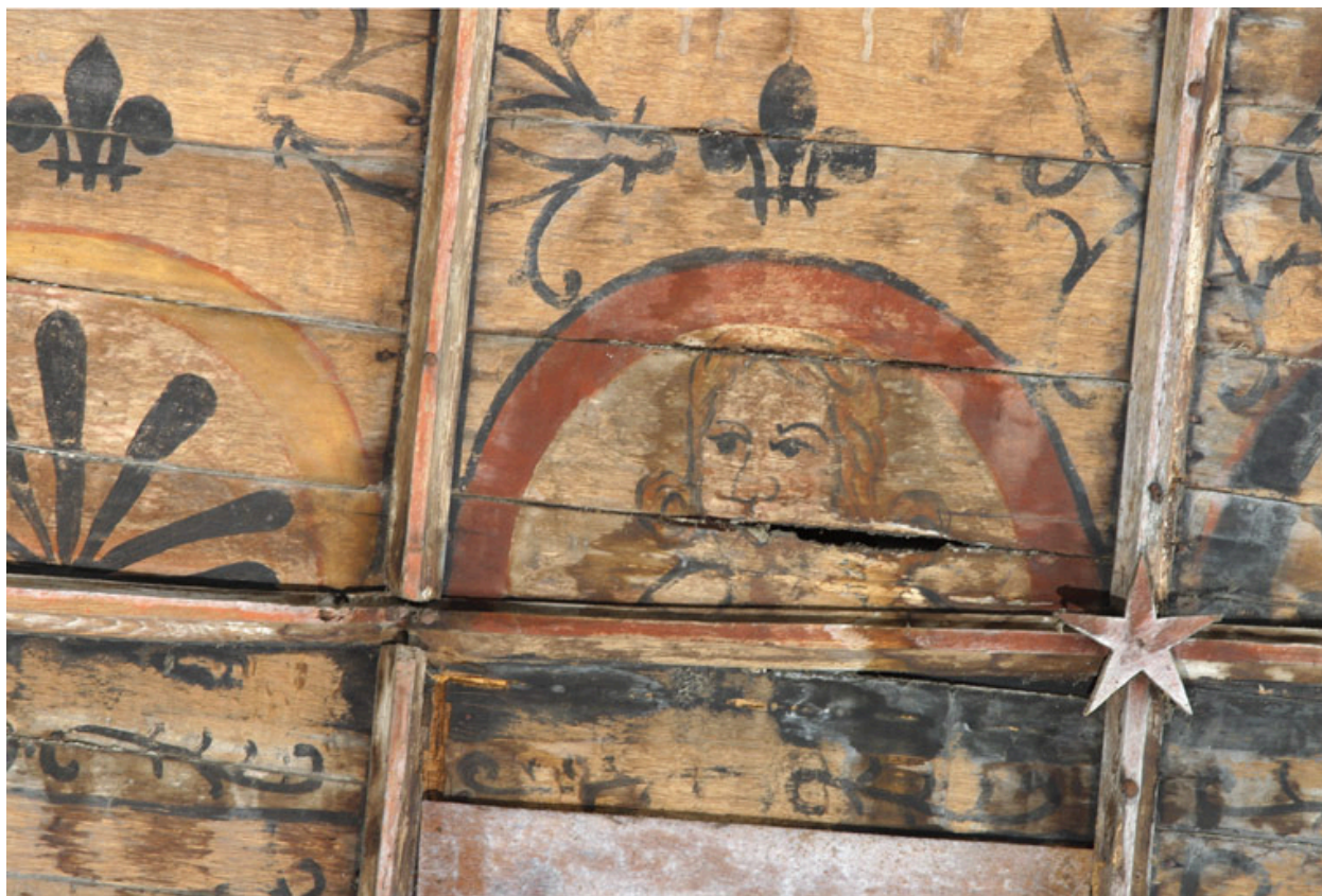
Nef, voûte, côté sud, quatrième travée, registre supérieur : tête d'homme.
