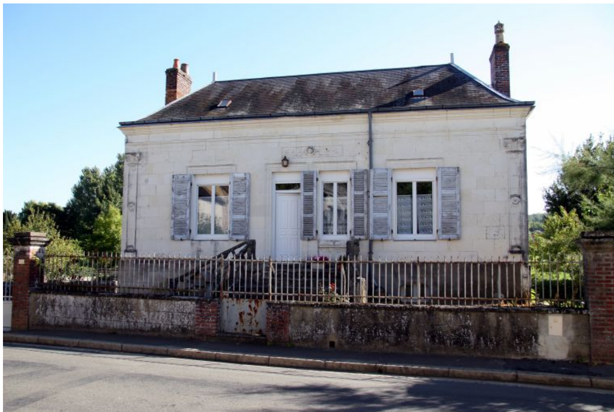
Vue d'ensemble sur rue.
