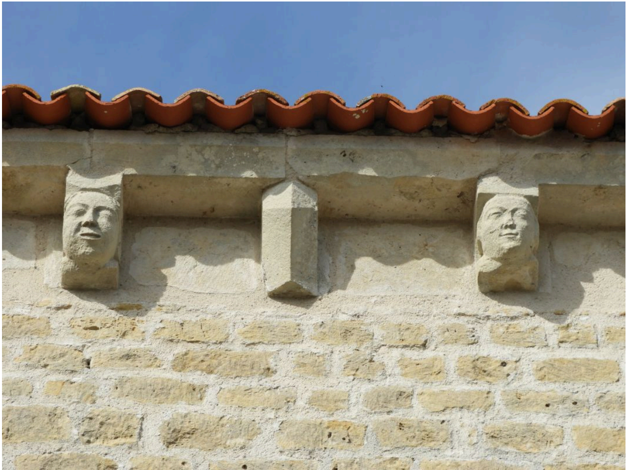
Modillons du mur sud de la nef, d'ouest en est : vue 2.
