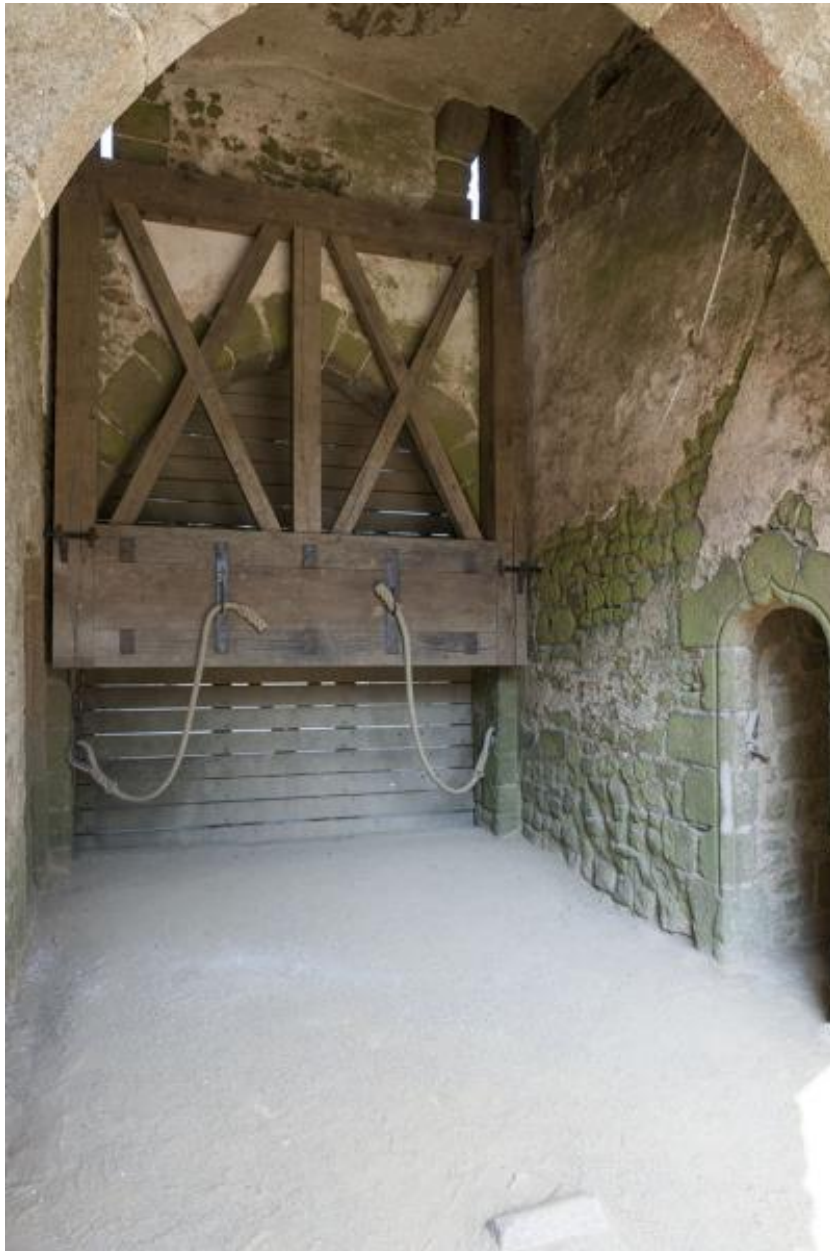
Pont-levis, depuis l'intérieur de la cour.
