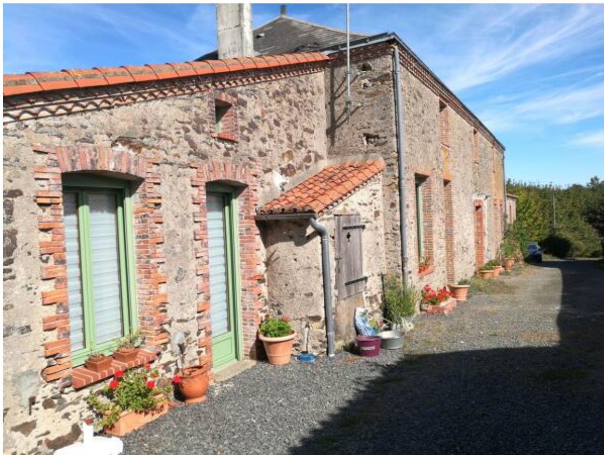
Le Long-Douet. Vue du logis, du puits et du cellier.
