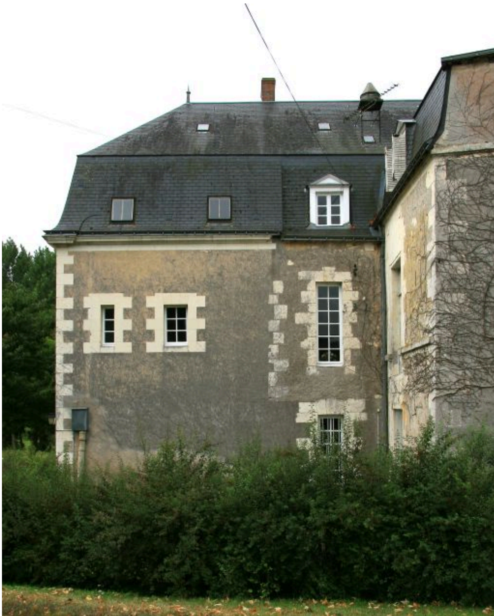
Aile est, face nord : travée de l'escalier sur les fossés.
