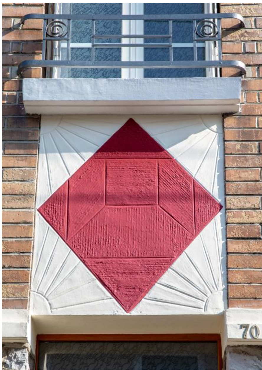
Détail d'un décor de stuc sur une des maisons individuelles du lotissement dit Fournier.
