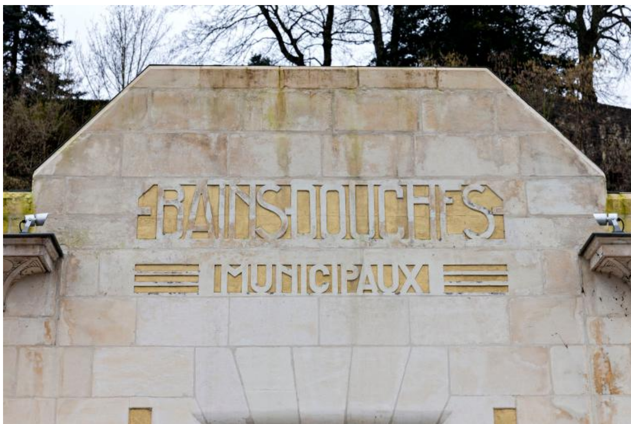
Les bains-douches restaurés. Elévation antérieure, vue de détail : fronton.
