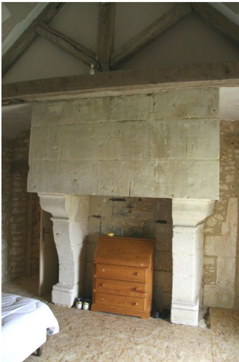
Ancien château, partie centrale, 1er étage, chambre 2 : cheminée de la fin du XVIe siècle.
