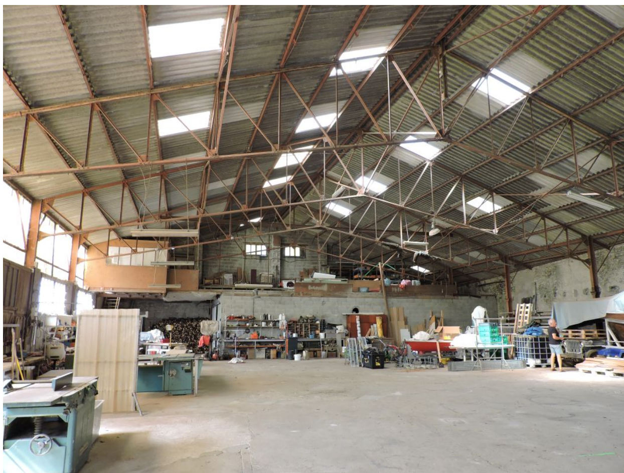
Vue intérieure du bâtiment en direction du sud-ouest.
