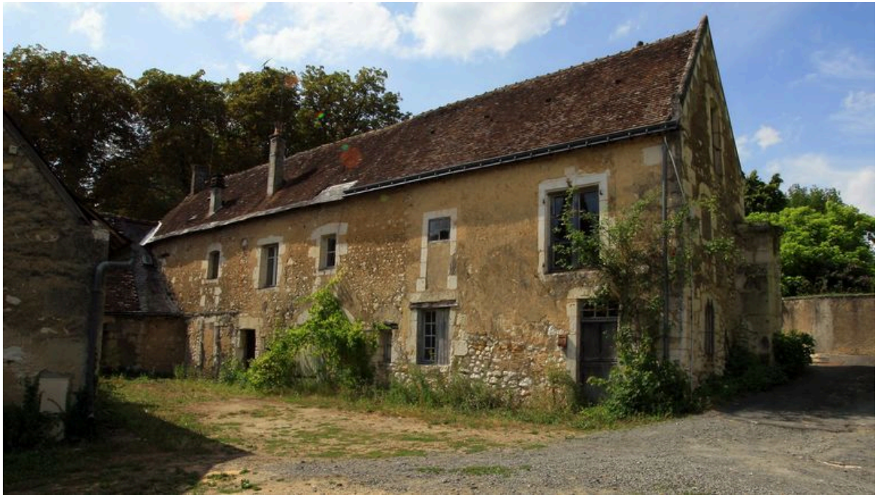
Façade antérieure sur cour.
