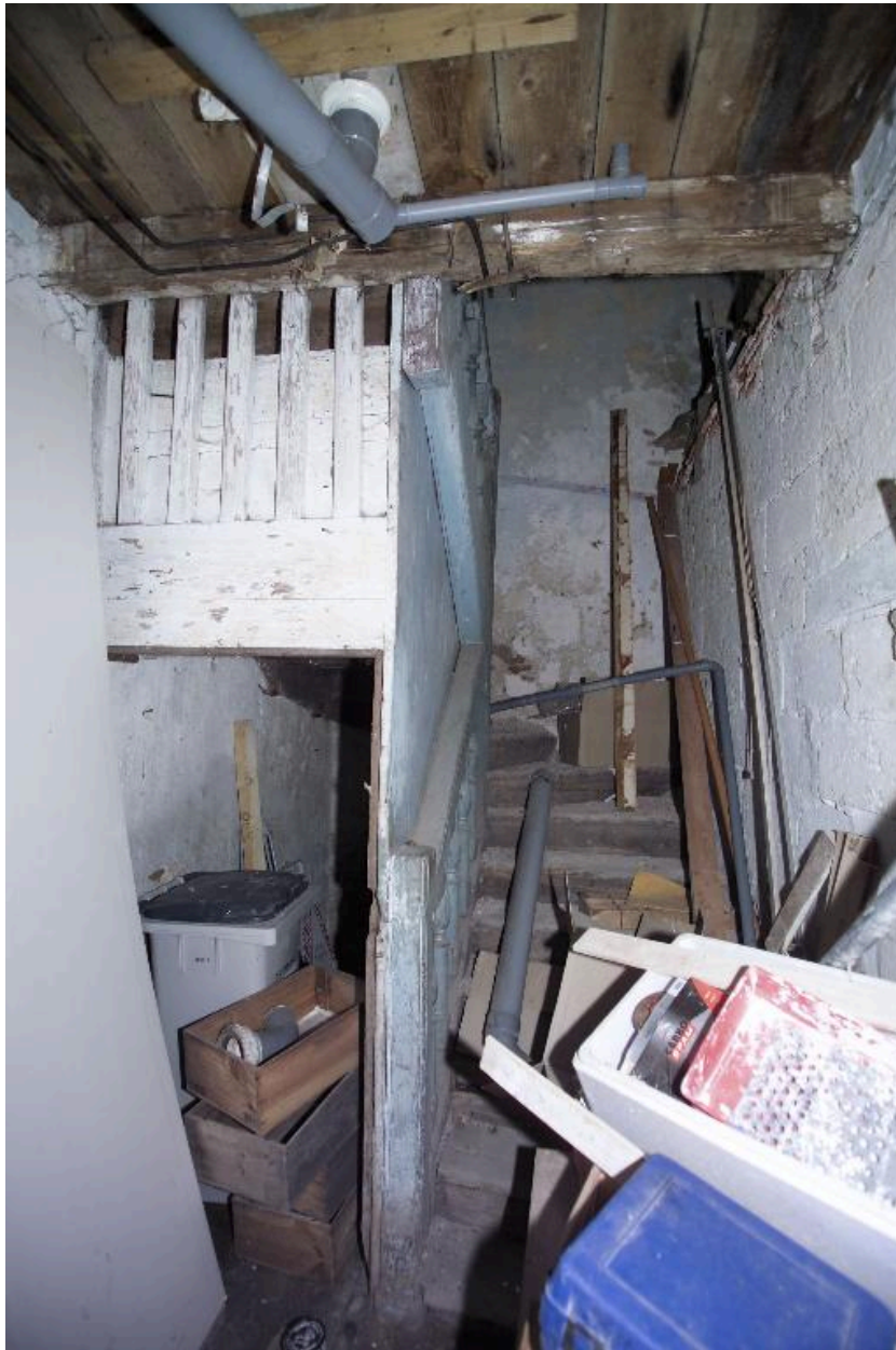
La maison n° 30 rue du Faisan, la deuxième entrée, l'escalier.
