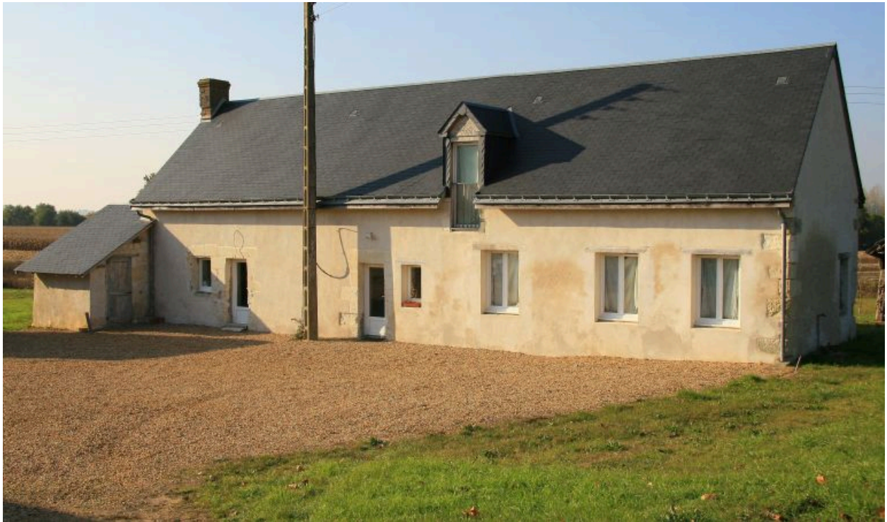
La maison : façade sur cour.
