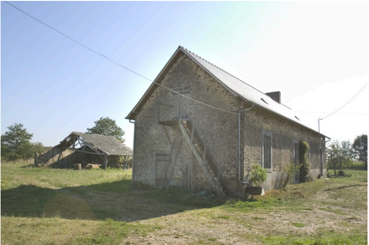
Le logis et la remise, ruinée.
