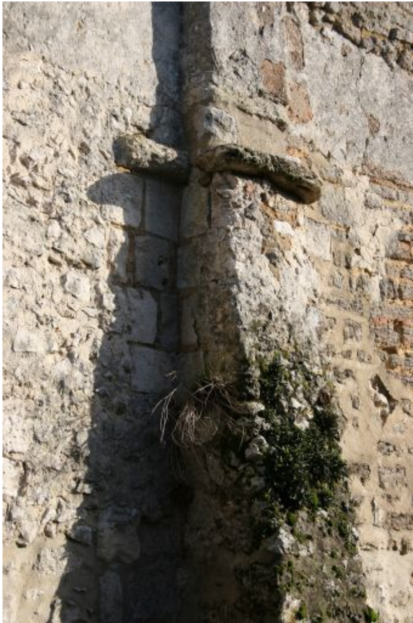
Mur sud de la nef : contrefort.
