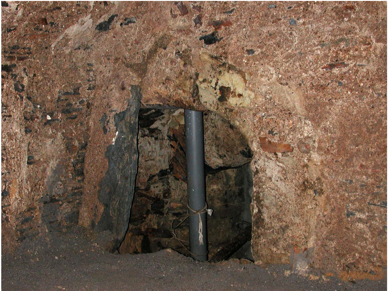
Sous-sol, angle postérieur gauche (sud-est) : partie supérieure d'une porte condamnée.
