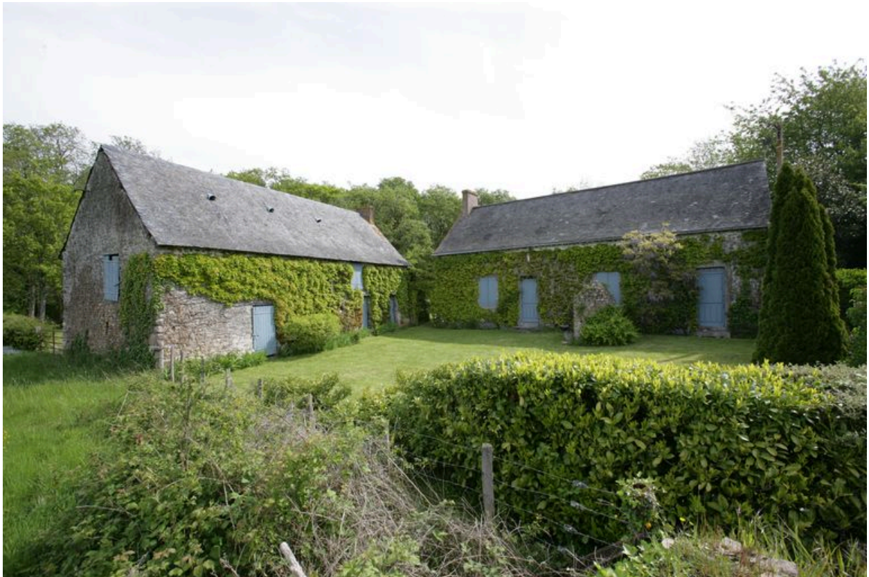
Vue d'ensemble depuis le sud-ouest : l'ancien logis-étable, le logis.
