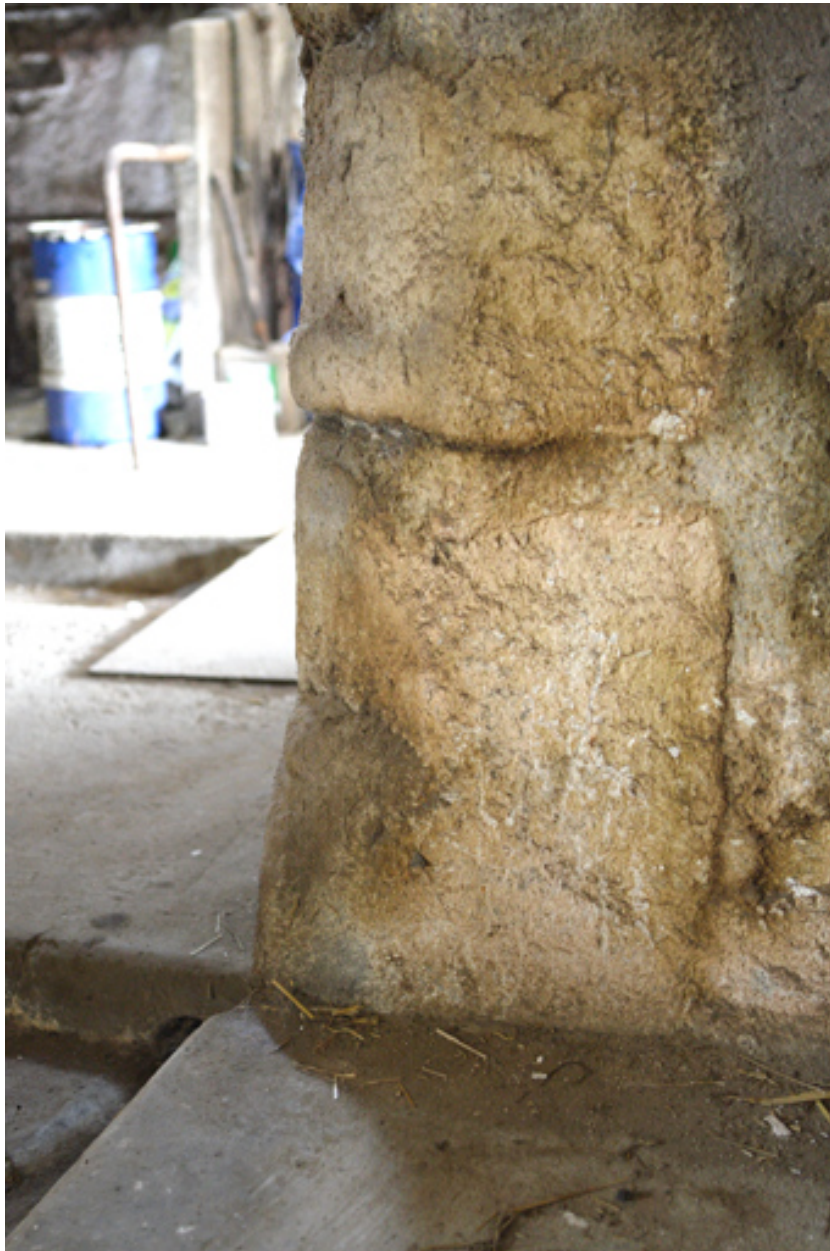
Cheminée. Chanfrein à la base du tableau de droite, détail.
