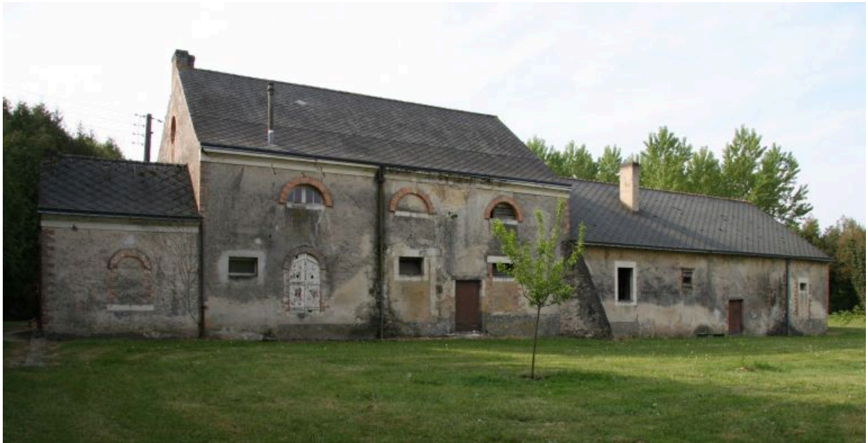
Façade postérieure en surplomb.
