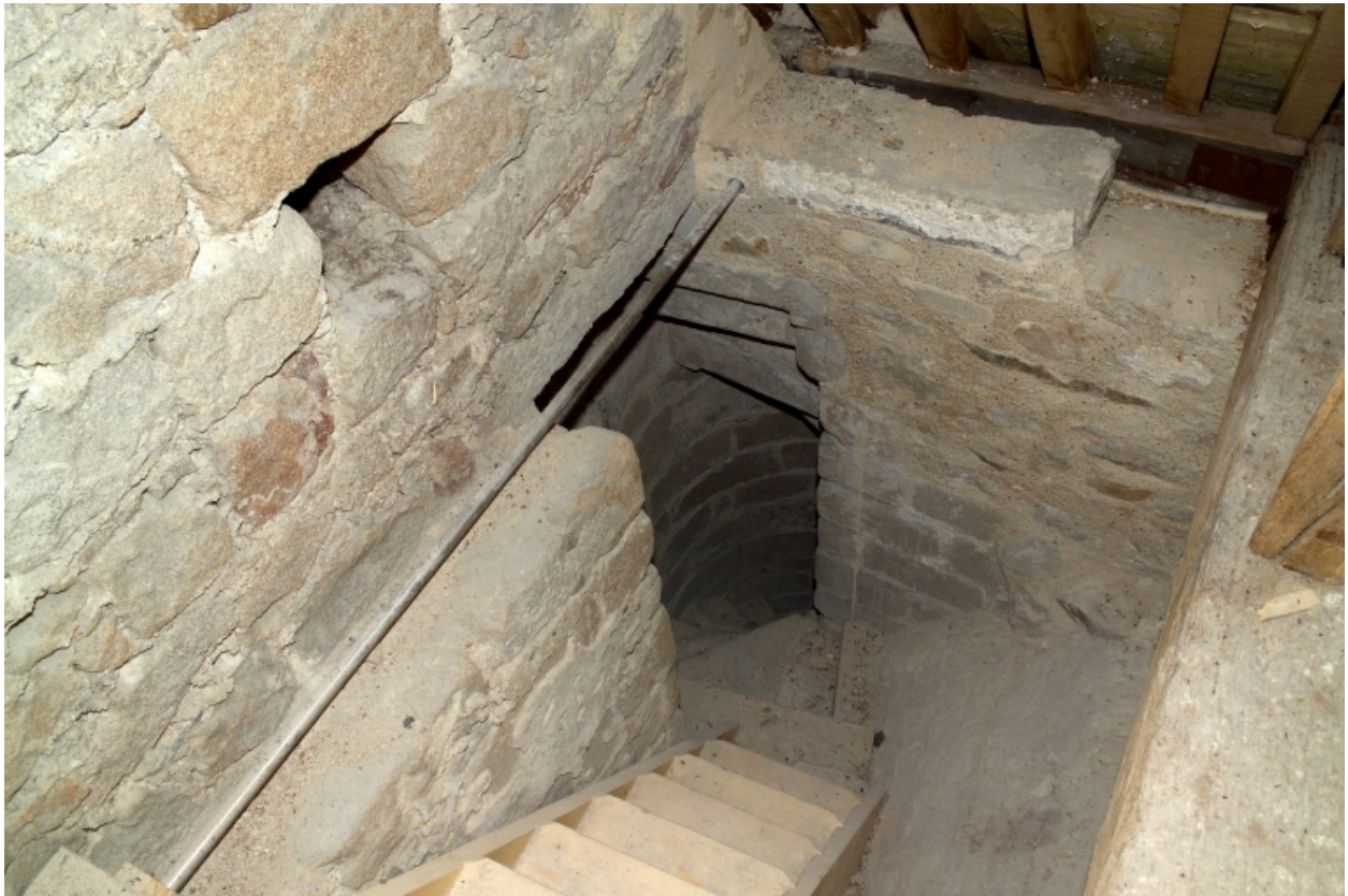
Sommet de la vis depuis les combles.
