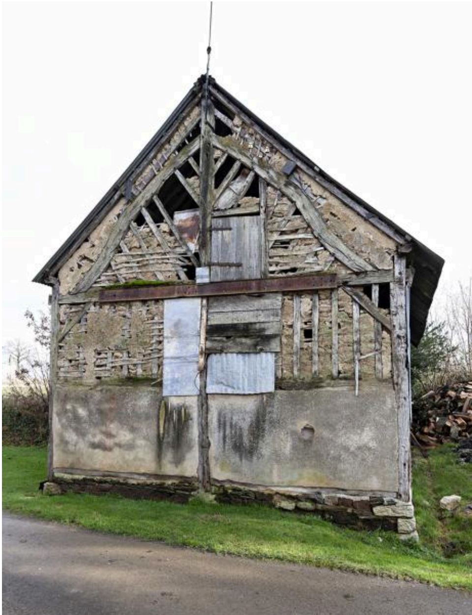
Remise en pan de bois de la Guiberdière, mur-pignon.
