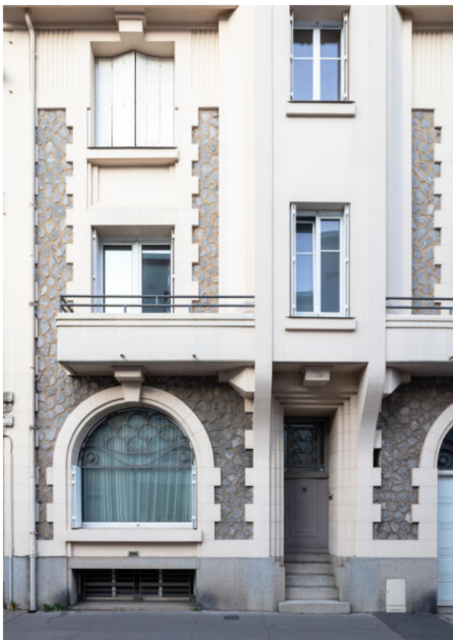
Détail des deux travées nord.
