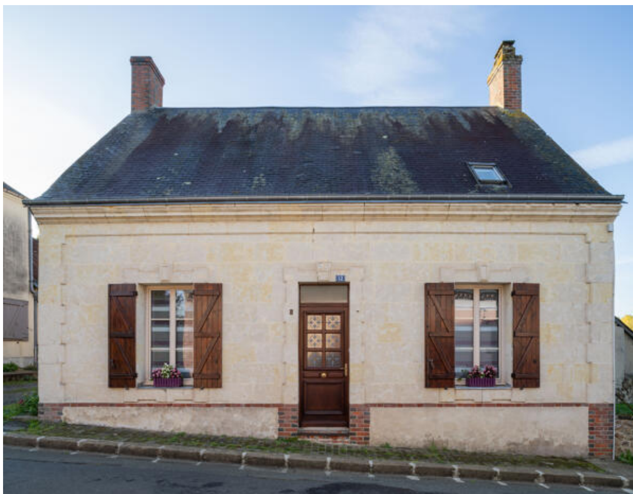
Façade de maison en pierre de taille calcaire, 12 rue de la Petite Fontaine.
