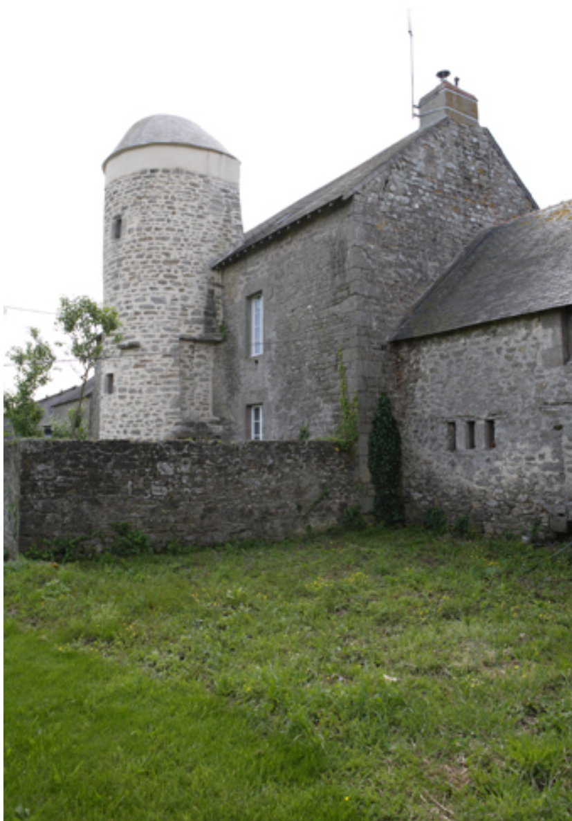
Logis. Vue de trois-quarts depuis le nord-ouest.
