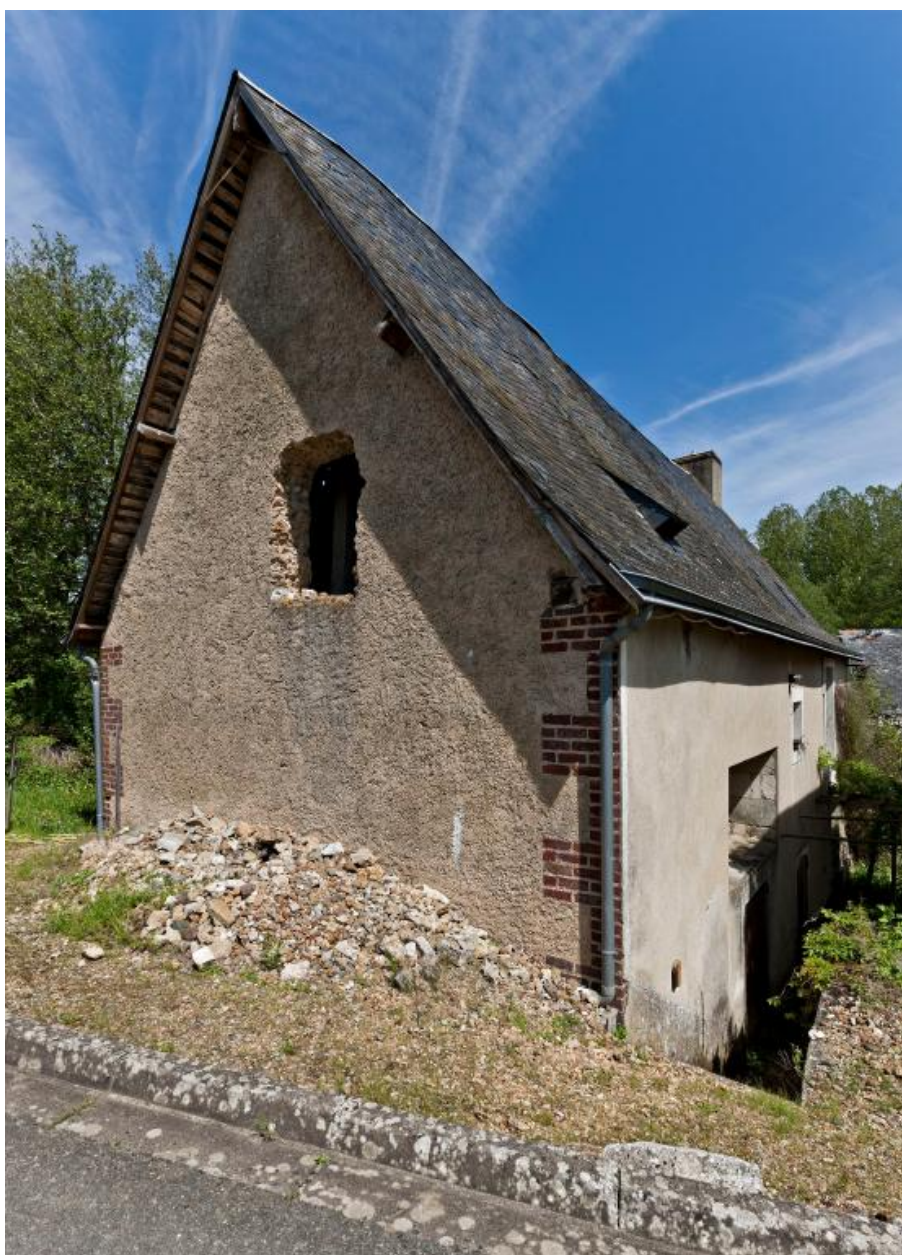
Vue de volume du bâtiment accolé à l'ouest du logis ancien.
