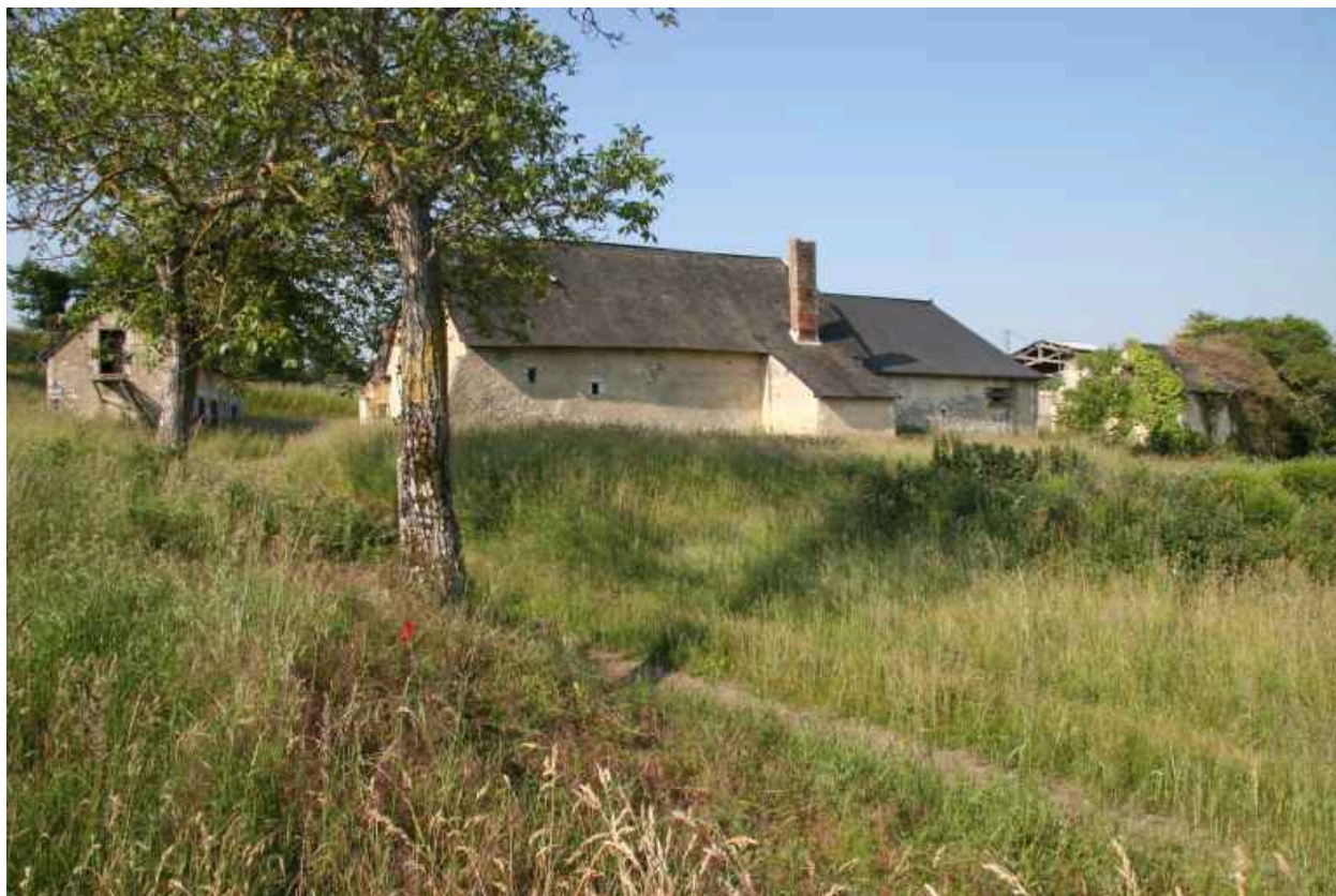
1ère maison et toit à porcs : vue d'ensemble.
