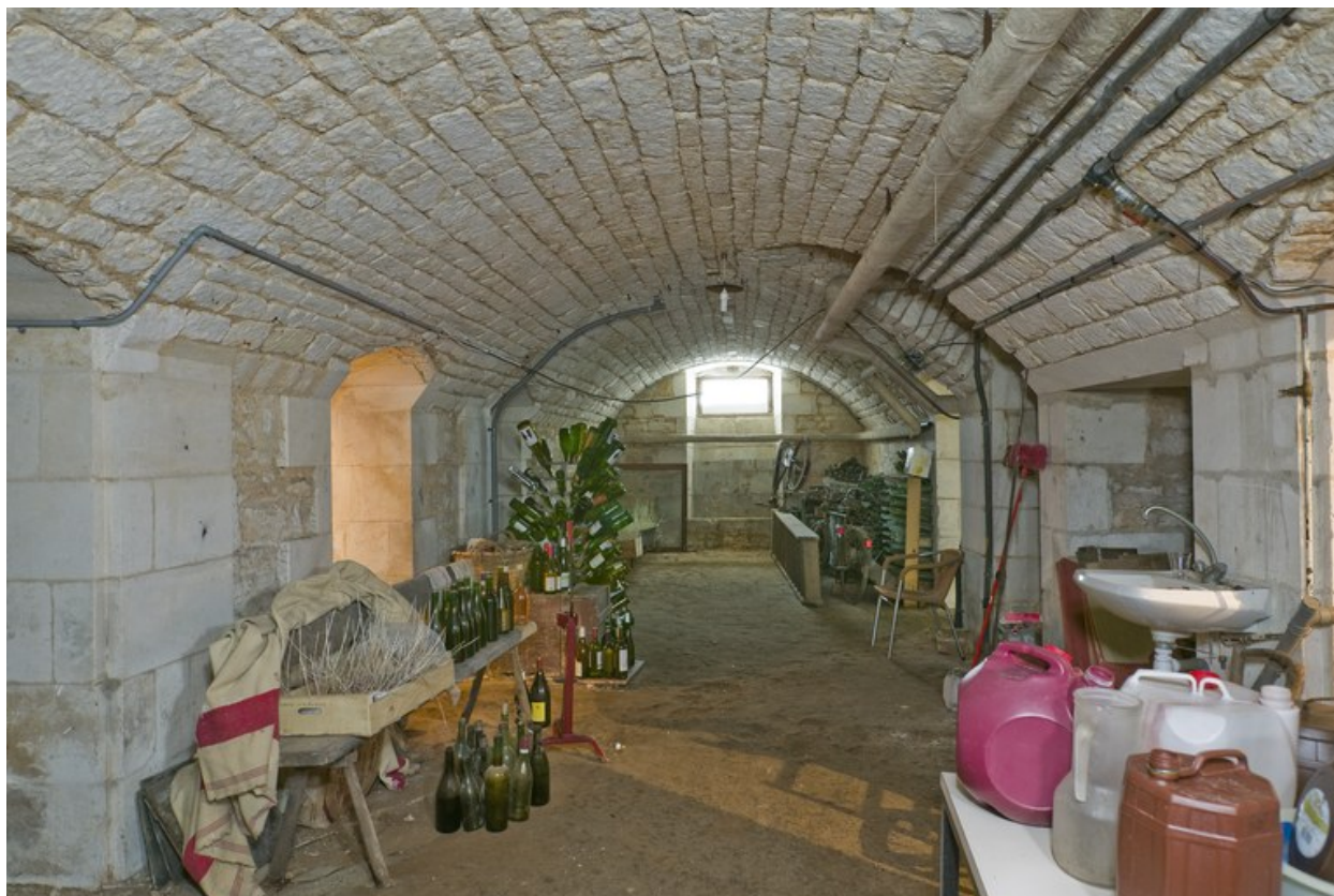
Vue du sous-sol.
