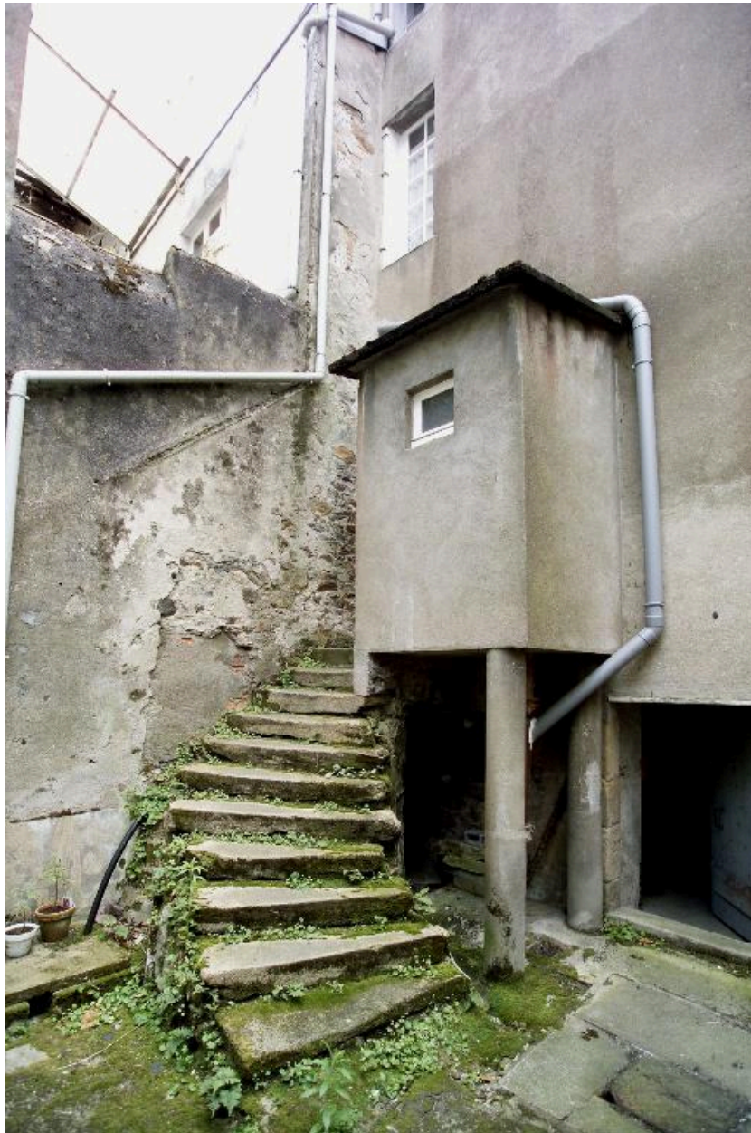
L'escalier d'accès à la cour.
