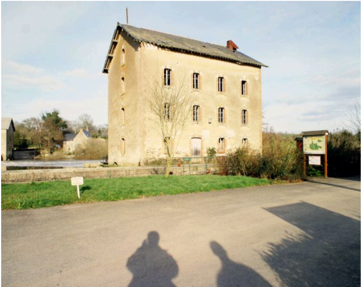
La façade sud-ouest du moulin, en 2002.
