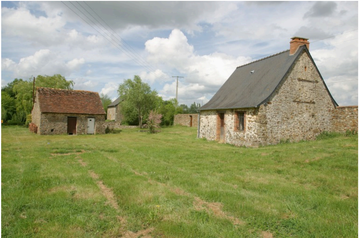
La porcherie et le logis 4 vus du sud. Au fond, la construction située au nord de la mare.
