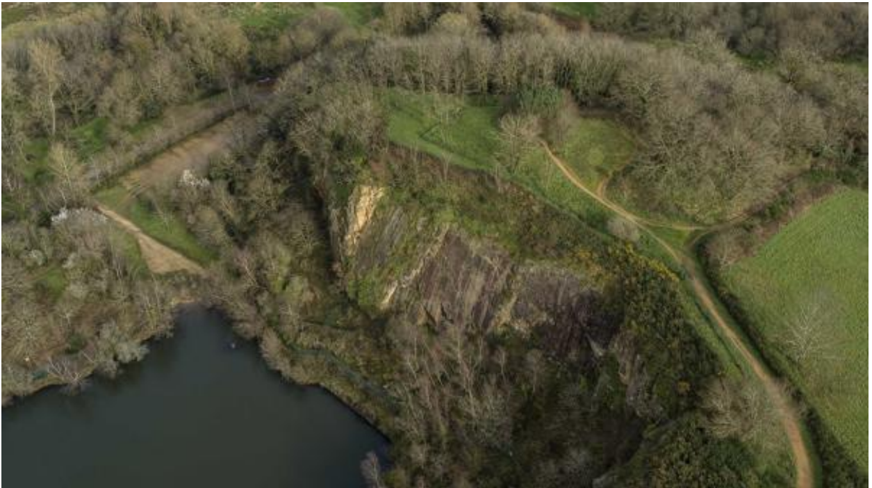
Vue aérienne du front de taille.
