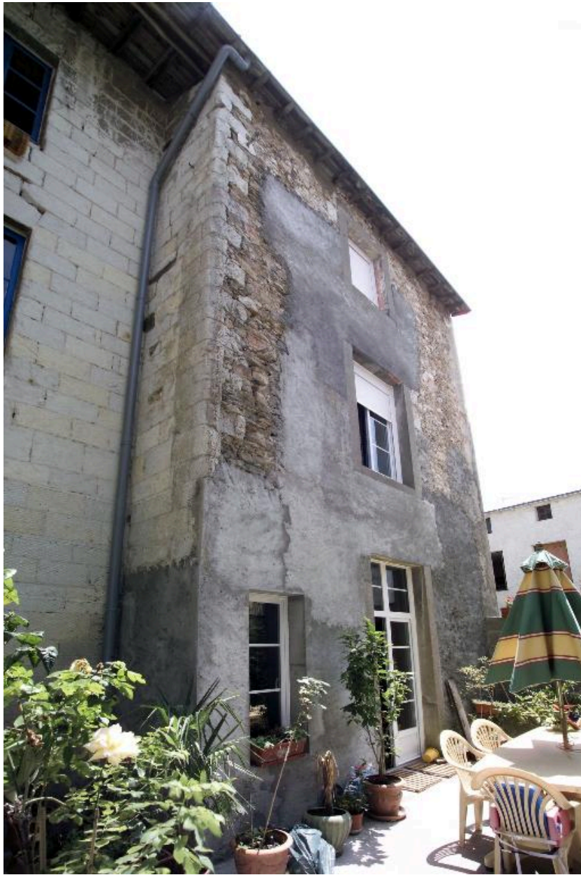
La façade du corps secondaire.
