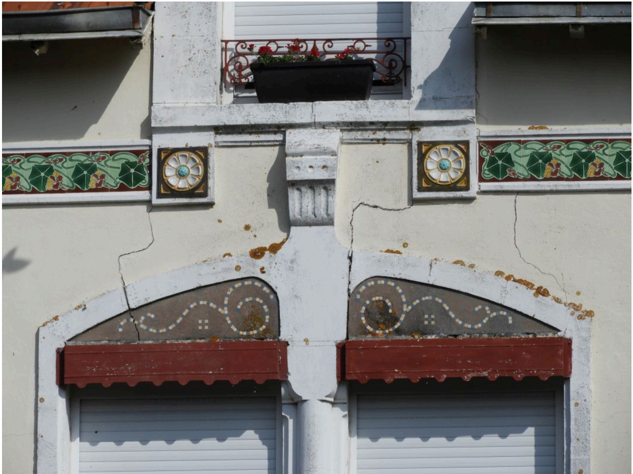
Détail de la façade : garde-corps en ferronnerie, frise en céramique, impostes à volutes, baie jumelée.
