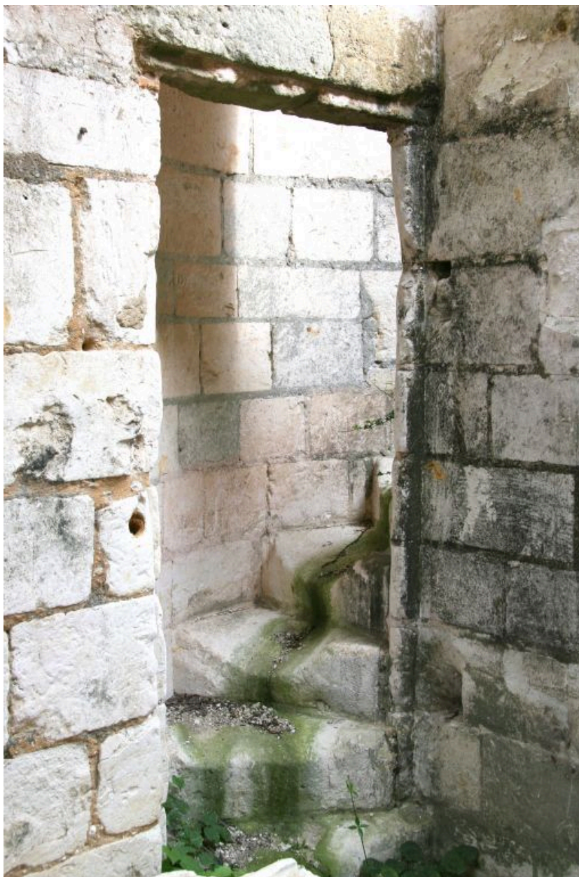
Ancien château, 1er étage : escalier tournant.
