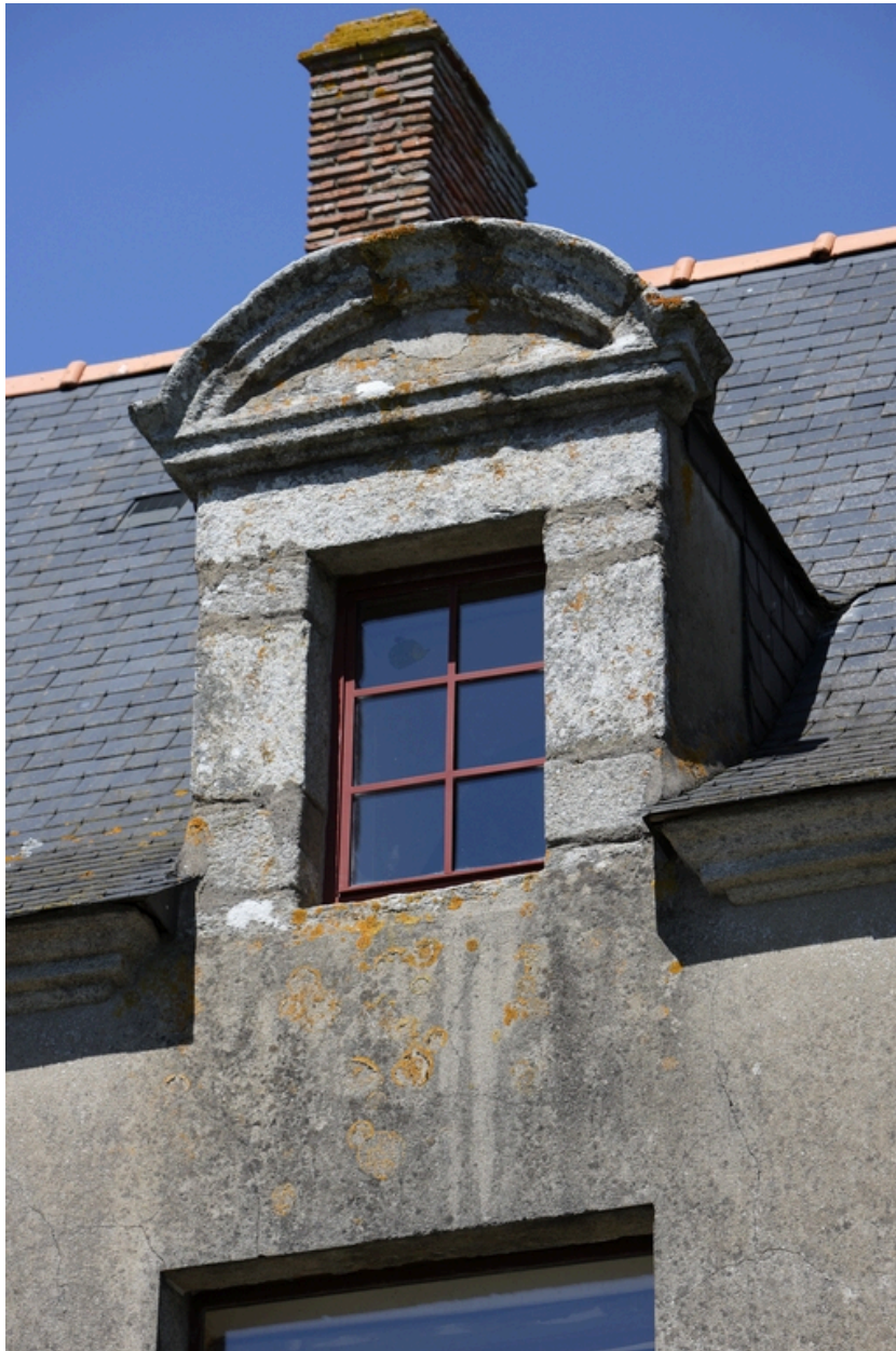
Logis. Façade sud. Détail de la troisième lucarne.
